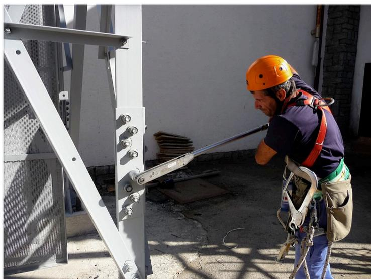
In casi particolari vengono eseguite anche verifiche di serraggio della bulloneria o di verticalità, con stazione topografica a telemetro laser.
