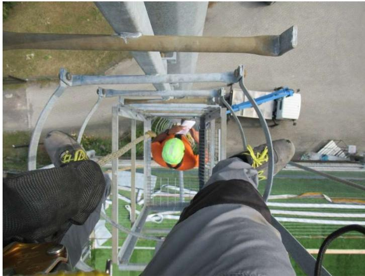
Piolo saldato su montante centrale con dente fermapiede in entrambi i casi; a sx la protezione è data dal guardiacorpo a dx è data cursore anticaduta EN 353 / 1 da inserire nel montante centrale
