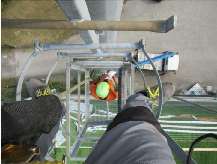
A dx è presente un vero e proprio sistema anticaduta, la caduta segue una meccanica tale da portare il rischio di danno fisico ad un valore ridotto e più accettabile (anche se non azzerato). Il dente ha vertice stondato.
